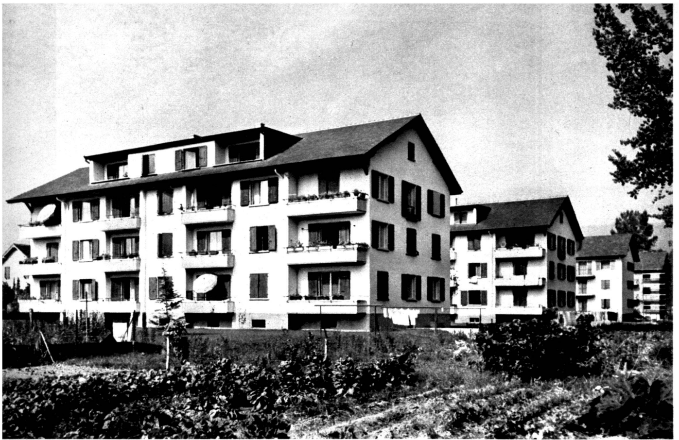
Vue générale de la cité d'habitation.
