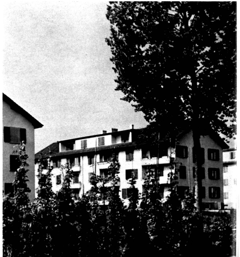
Vue d'un immeuble du type 1-2.
