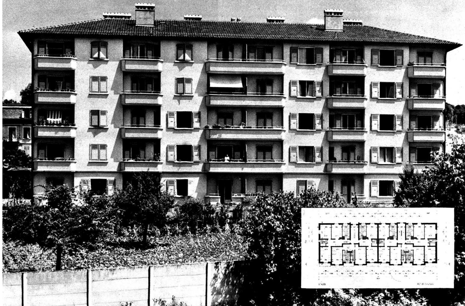
Façade principale de l'immeuble.
