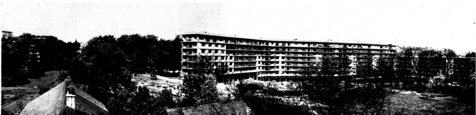
Vue générale du groupe en construction.
