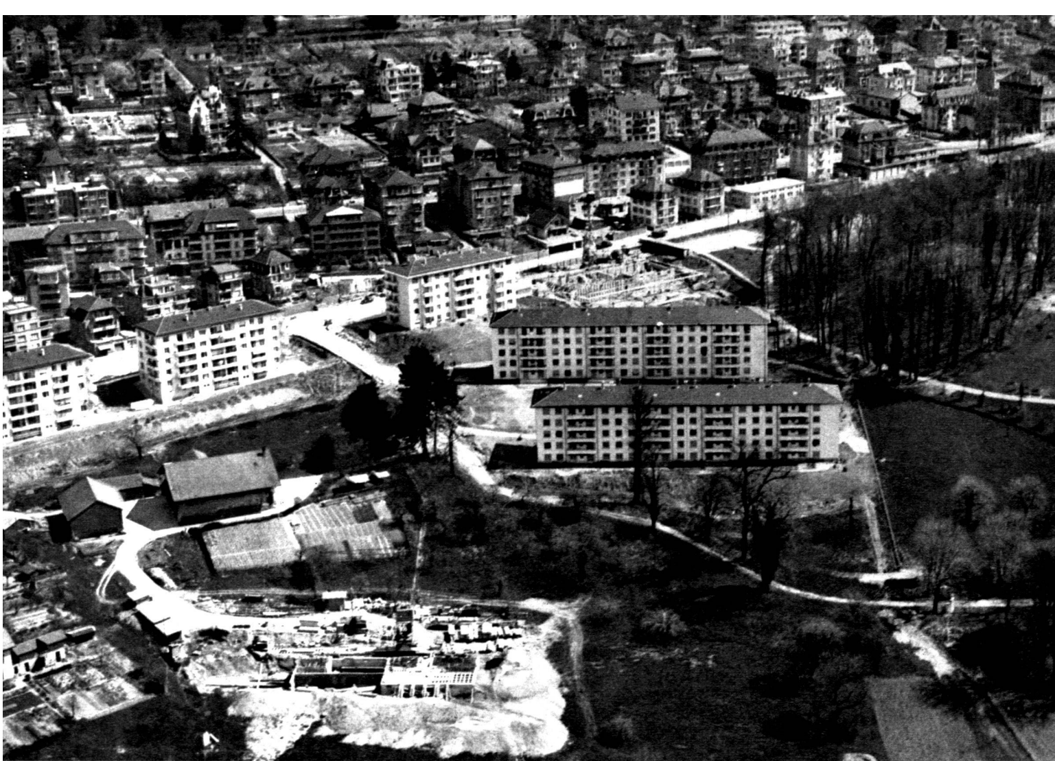
Vue générale du quartier. Photo Wurgler.
