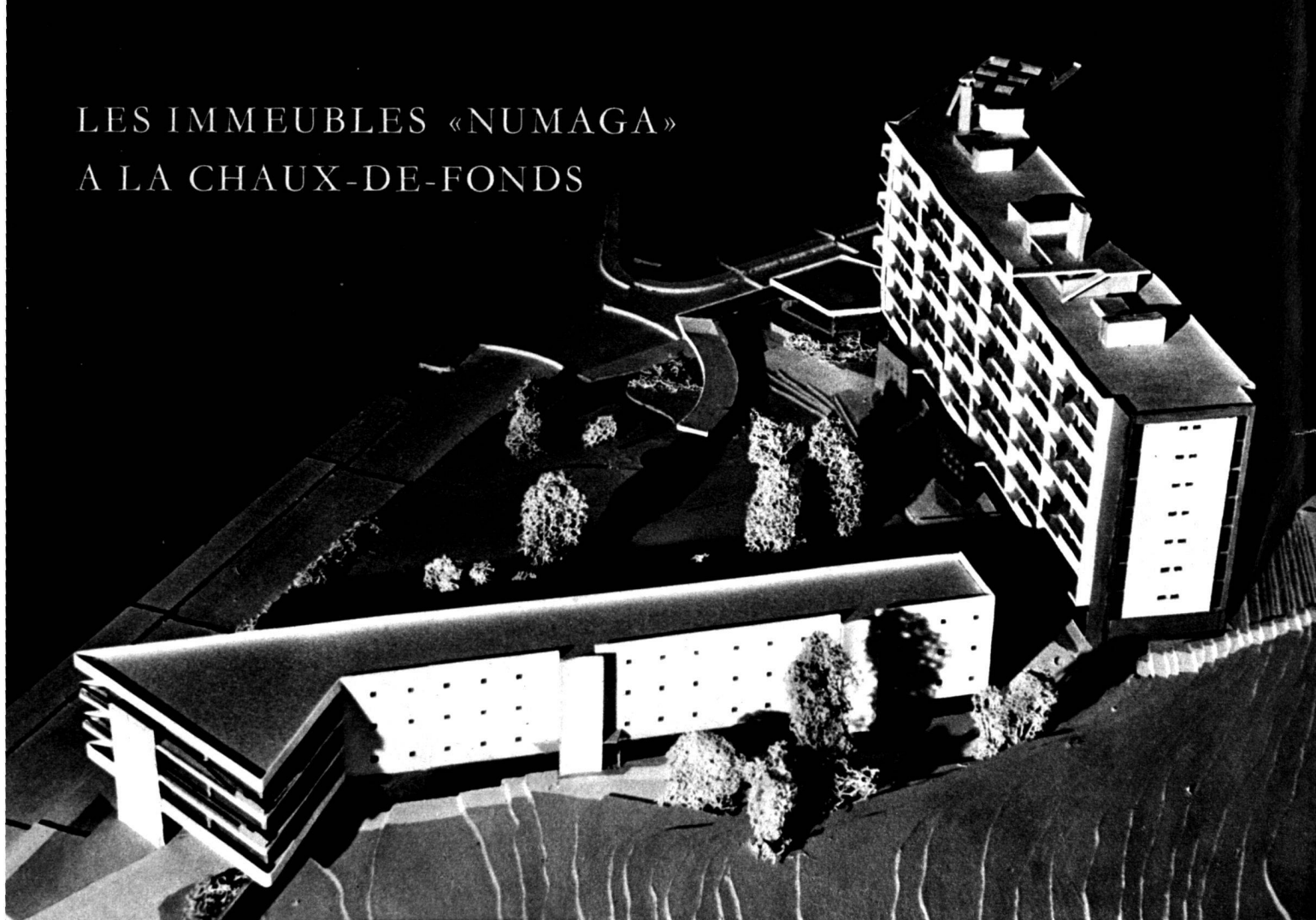
Vue générale. Au premier plan, Numaga 3 et 4 (Photos Fernand Perret, La Chaux-de-Fonds)
