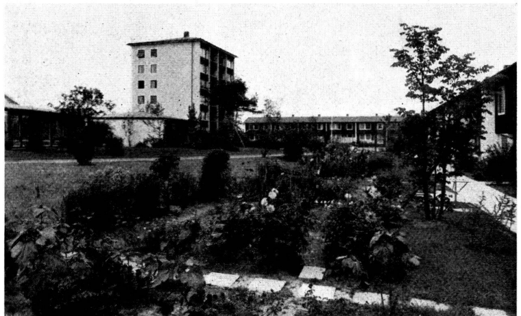
La forme spacieuse et variée d'une nouvelle cité d'habitation.
