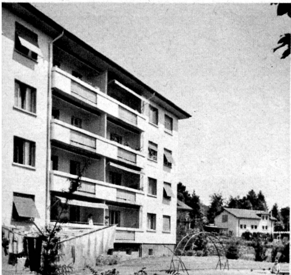
1-4 Photos « Habitation » 5 Photo Wurgler
