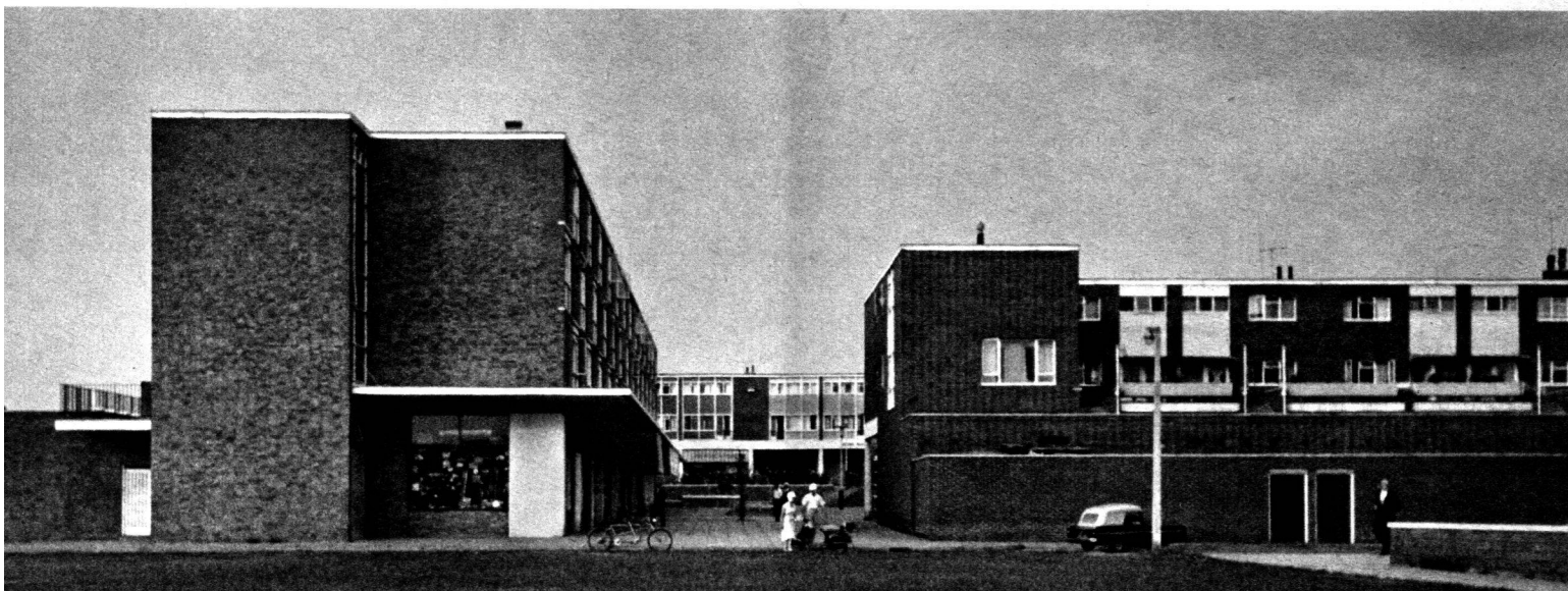
Ci-dessus: Quartier industriel et centre médico-social Ci-dessous: Entrée du Centre commercial
