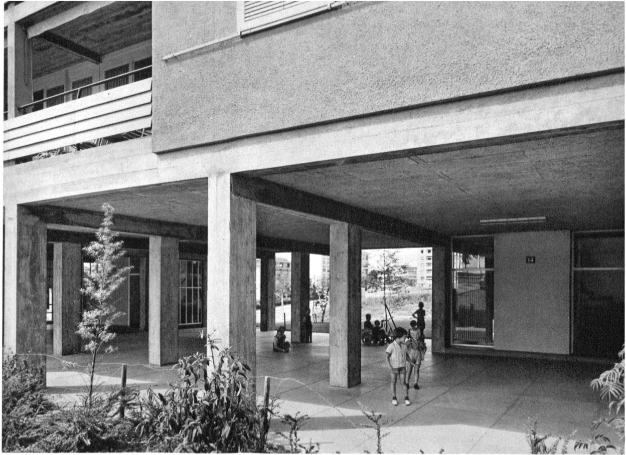
La Maison ouvrière à Bellevaux, Lausanne Immeuble chemin d'Entre-Bois
