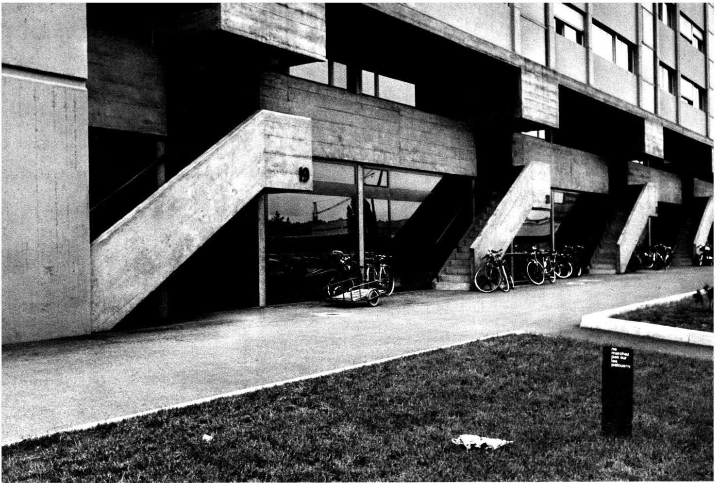
Détail du rez-de-chaussée
