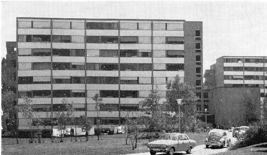
Agrandissement du bâtiment «Im Höfli», Langnau S. A. Revêtements de façades et balustrades de balcons «Pélichrome» blanc. Architecte: E. Eidenbenz, Zurich.
