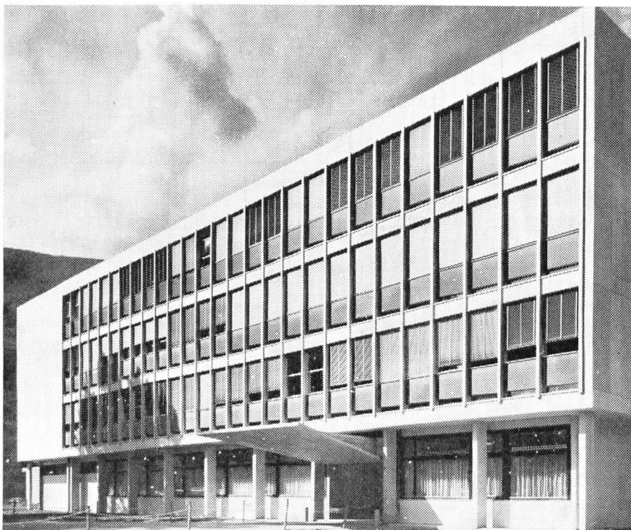
Centre de formation professionnelle, Sion. Éléments de façades «Aeroplac» avec couche extérieure «Pélichrome» rouge anglais. Architectes: P. Morisod et J. Kyburz, Sion.
