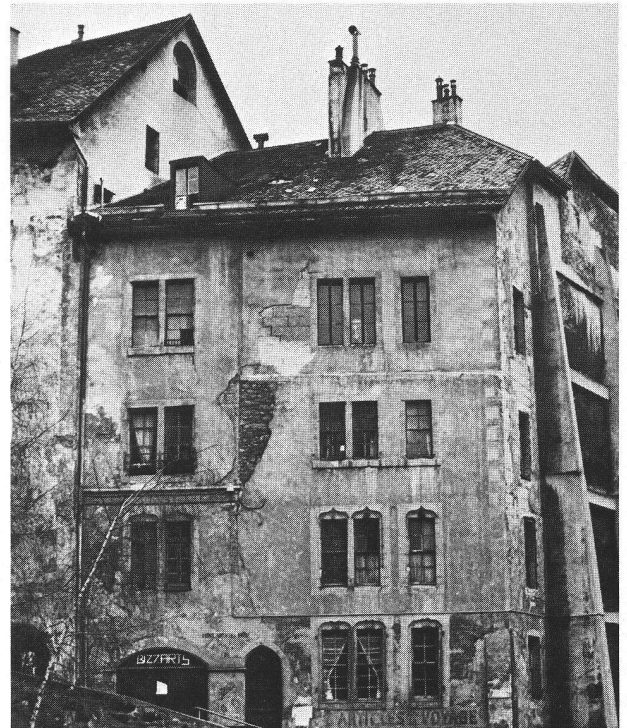
Pélissier No 18. Façades gothiques surélevées. Etat en 1976.
