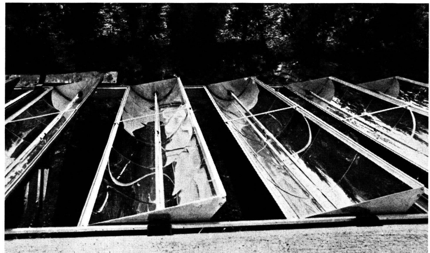
Installation de capteurs à concentration à Grandvaux. Les 52 m 2 de capteurs orientables (est-ouest) sont inclinés à 41° et alimentent un stock de 15 000 l. (Photo: Kaladi.)
