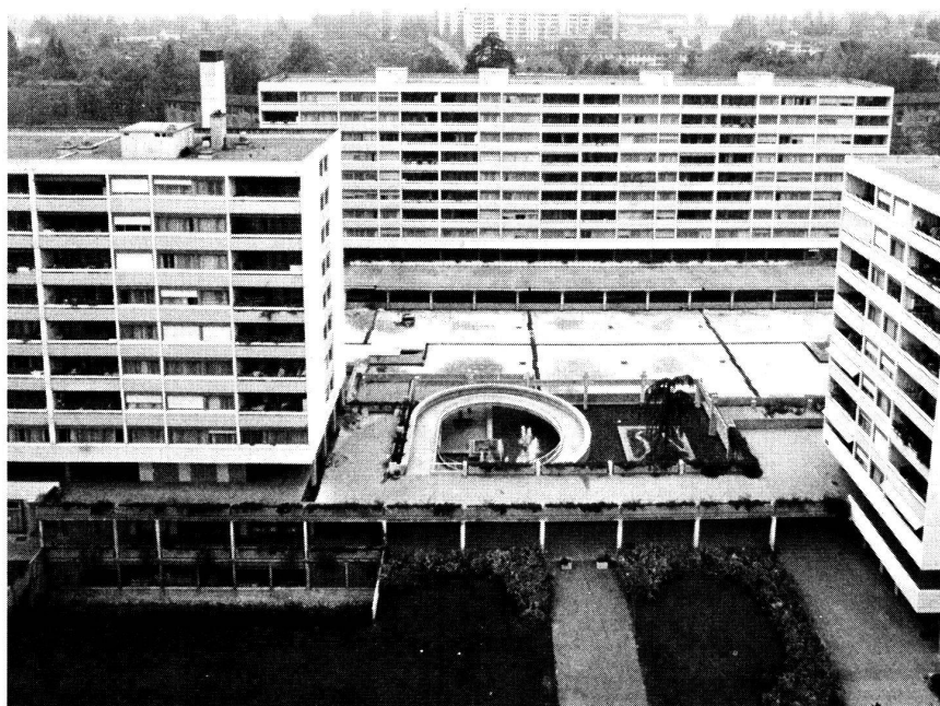
Vue d'ensemble du centre de la Cité Vieusseux, prise du haut de l'immeuble D.
