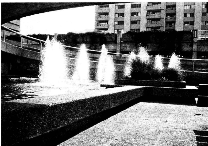
Vue du bassin et des fontaines ornant le centre du quartier; ce bassin, outre son agrément, remplit une fonction technique: il permet le refroidissement de certaines installations de la centrale thermique.
