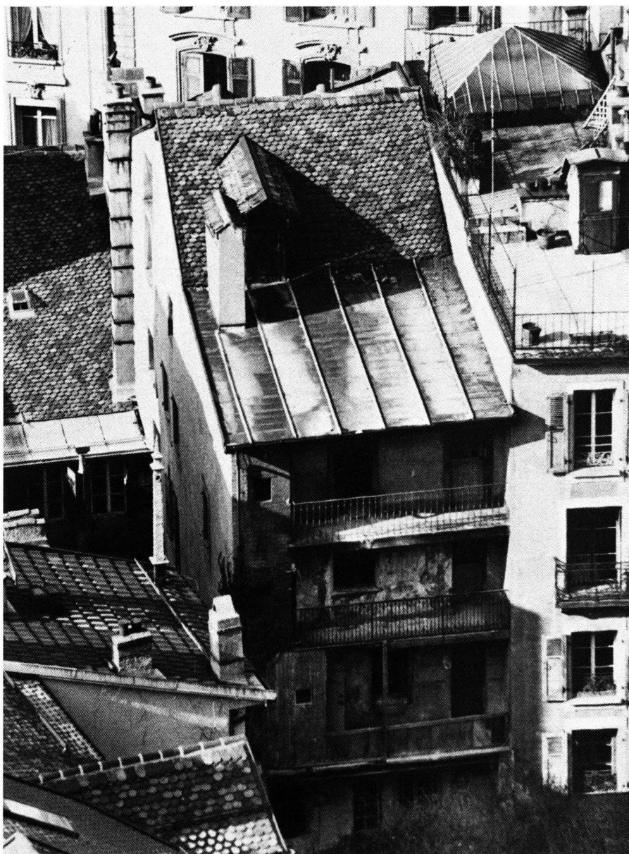
Façade est, sur jardin, avant la rénovation
