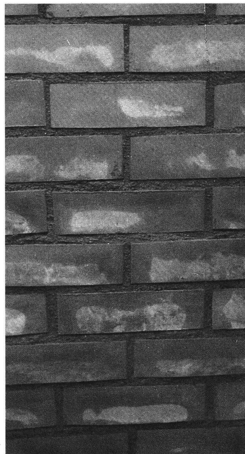
Vue de face d'un mur.
