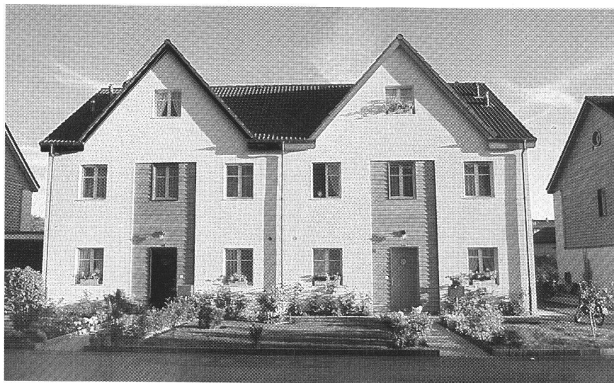
Fig. 12 — Façades sur rue.
