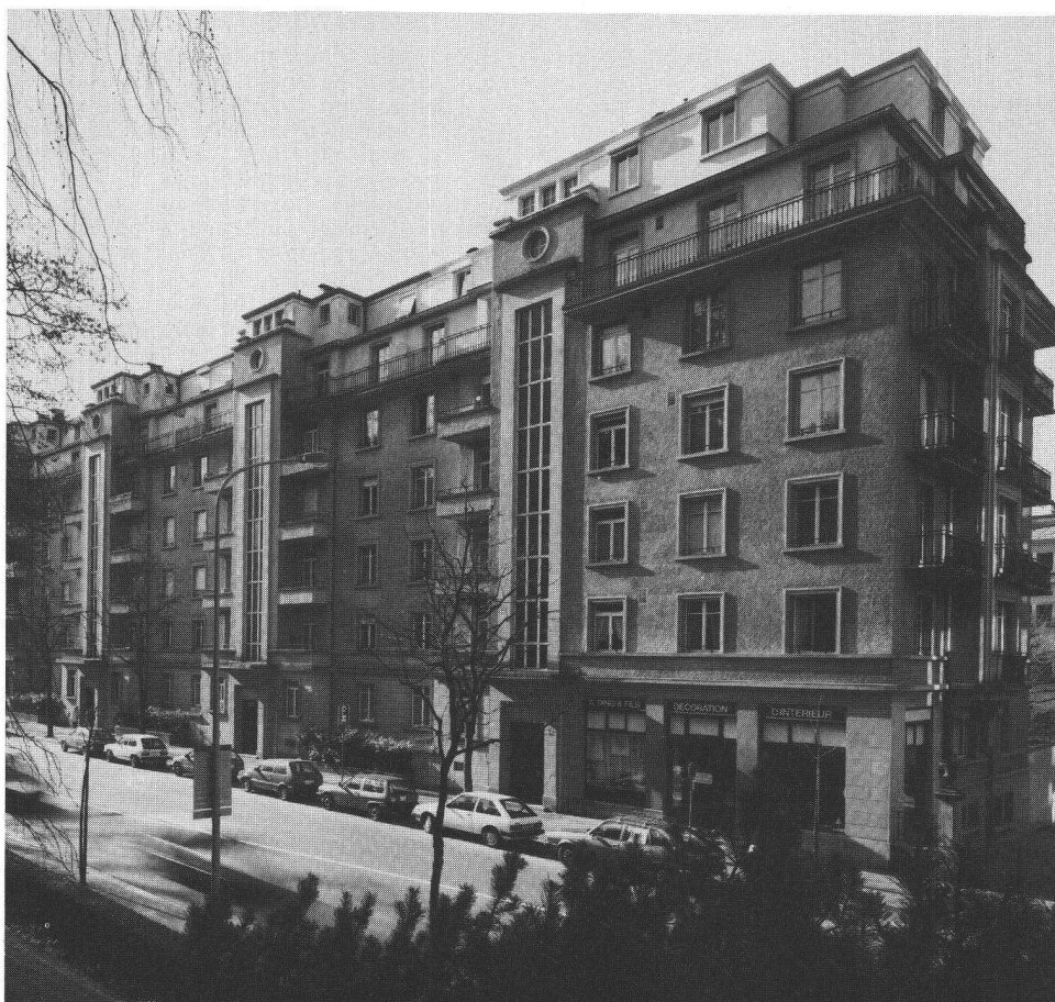
Vue de la façade nord.
