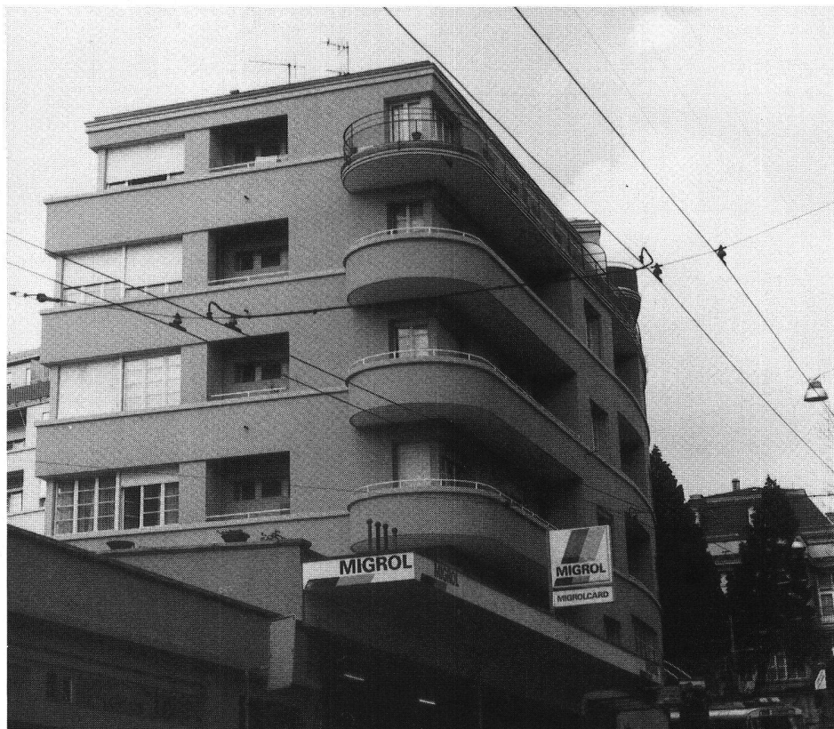
Vue des balcons en porte-à-faux.
