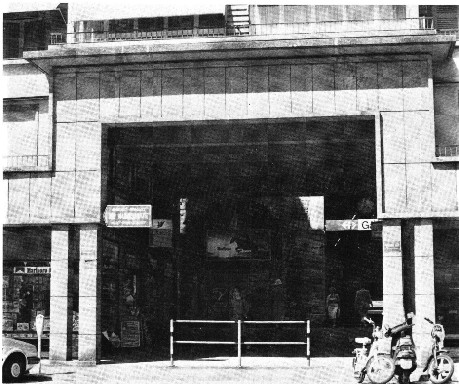
Vue du passage sous le bâtiment
