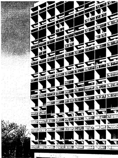
Détail de la façade est
