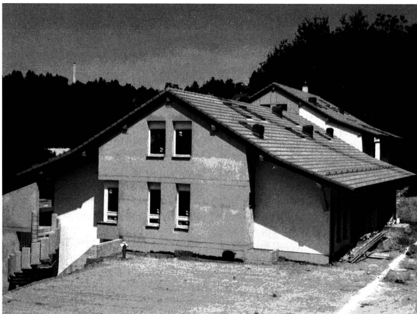
Bâtiment E (mitoyennes), première phase de construction. Habitable en septembre 1991, premier coopérateur 15 août 1991
