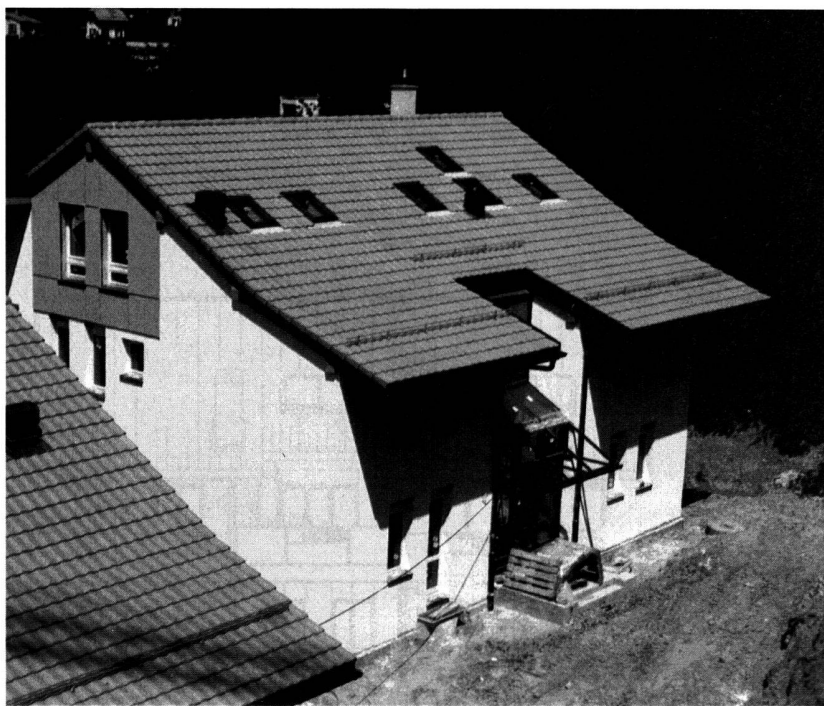
Bâtiment D (à gauche bâtiment E/mitoyennes), première phase de construction. Habitable en septembre 1991, premier coopérateur 19 août 1991
