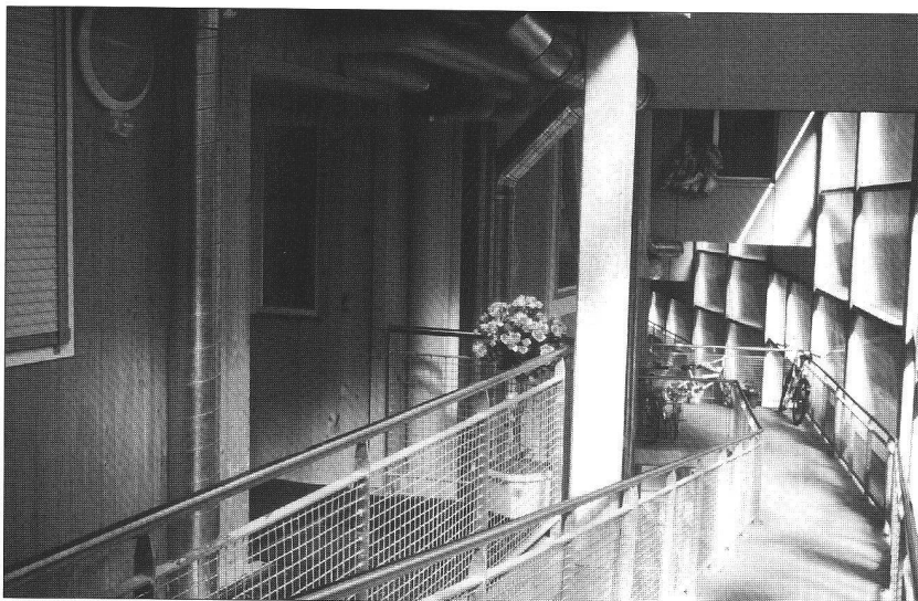
La construction en ellipse (photo du haut) est imposée par des données pratiques remarquablement interprétées. Ci-contre: une autre vue de la coursive.
