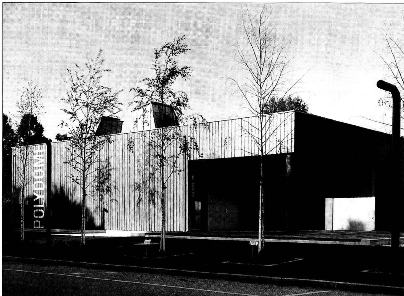
Annexe au Polydôme de l'EPFL, Ecublens 1997 - Maria Zurbuchen-Henz & Bernard Zurbuchen, architectes Photo : Walter Mair
