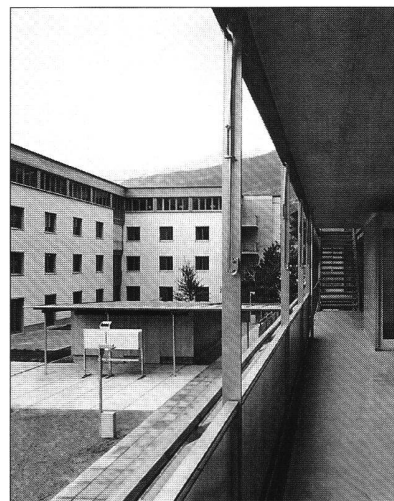
Ci-dessus : à gauche la façade côté chambres, l'espace extérieur collectif et la «Laube»
