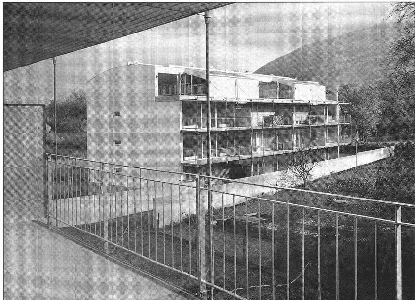
*Ci-dessous : le plan de l'immeuble est correspond au principe du type de base. Les appartements sont desservis par deux escaliers ouverts à partir desquels de petites passerelles conduisent aux entrées. Au rez-de-chaussée se trouvent des studios conçus selon le même principe.*
