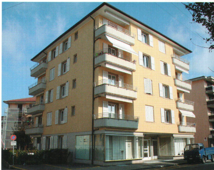
La plupart des bâtiments ont été construits dans les années 50. Suite aux travaux de rénovation, et notamment le renforcement des isolations périphériques, ils devraient être en état pour les trente prochaines années.
