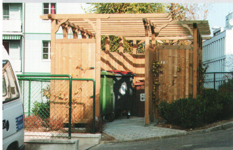
Les aménagements extérieurs, comme ici une zone de récolte pour les déchets qui sera cachée par des plantes grimpantes, ont été réalisés de façon à se fondre dans le quartier.
