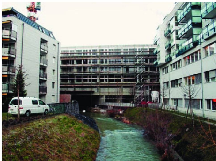
L'immeuble fait pont au-dessus de la rivière.
