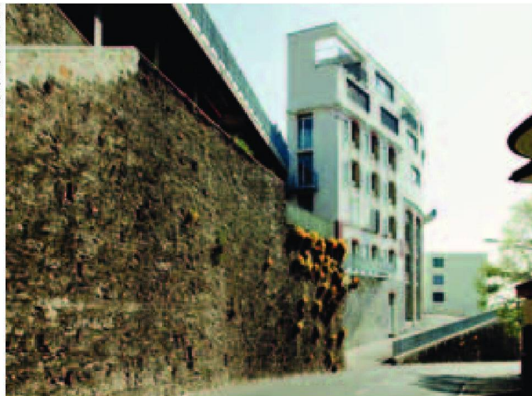
Quartier Ecoparc à Neuchâtel : la transformation d'un ancien immeuble artisanal a permis de créer une dizaine de lofts qui bénéficient du dégagement généré par la continuité morphologique de l'édifice avec les murs de soutènement du plateau ferroviaire. © Bauart Architectes et Urbanistes SA.
