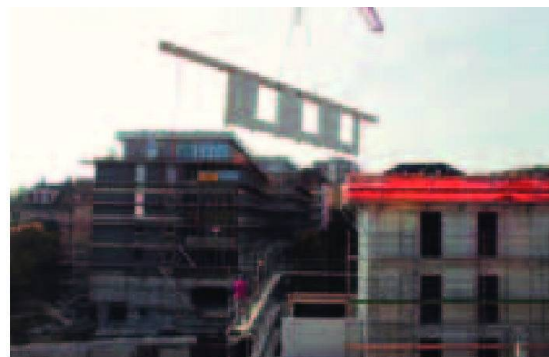
Les immeubles en chantier à l'Avenue Victor-Ruffy.
