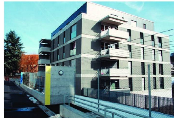
L'un des immeubles au label Minergie-Eco du quartier de Maillefer.
