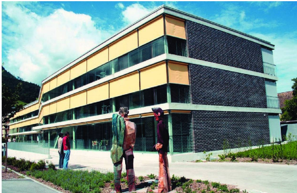
Briques et verre caractérisent la nouvelle construction de la SCH Alterswohnungen Mels, et l'art n'est pas en reste, avec les sculptures en bois de Peter Leisinger. © wohnen
