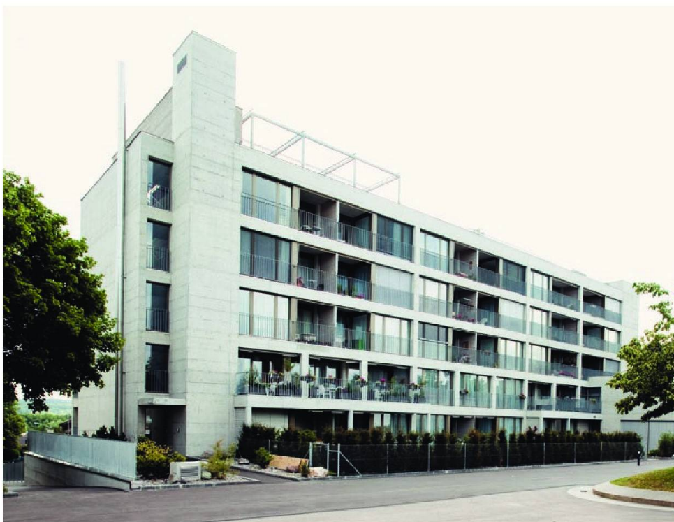
La façade sud-ouest, avec ses loggias, donne sur la tranquille place du village.
