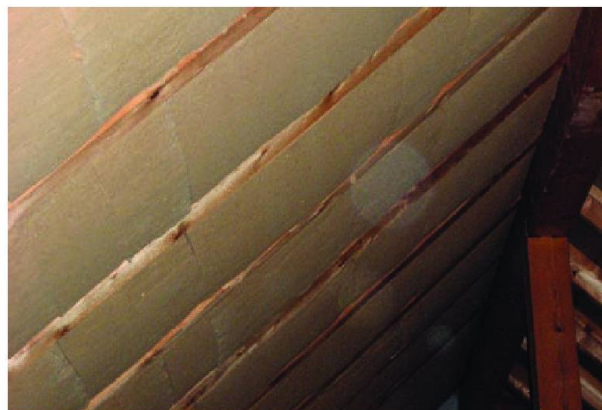
Isolation en fibres de bois entre chevrons avant la pose d'un frein-vapeur.
