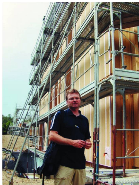
Ralph Thielen, pilote du projet, devant l'immeuble en construction, début juillet 2009. © Vincent Borcard
