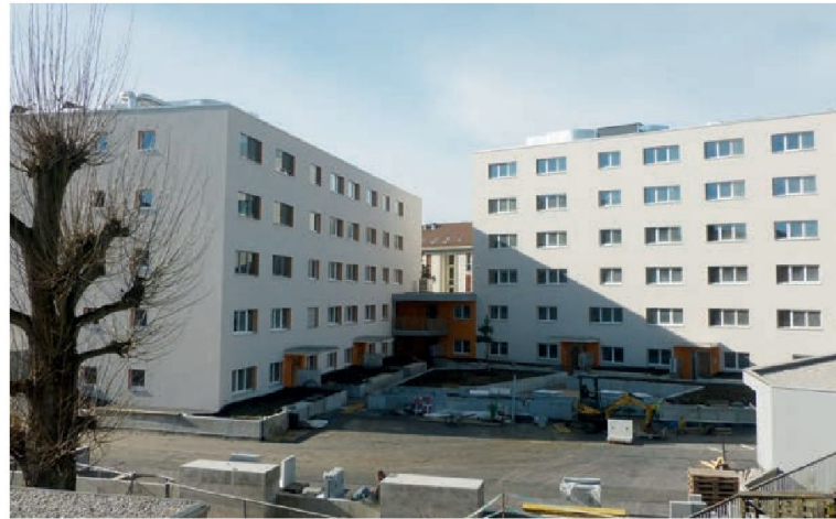
L'Oiseau de l'Ouest d'Ecublens comprend 54 logements. A l'articulation des deux bâtiments, la commune gèrera une crèche (au rez) et une salle de rencontre (au 1 er ). Quelques semaines avant les emménagements, la cour se préparait à accueillir ses espaces verts! © VB
