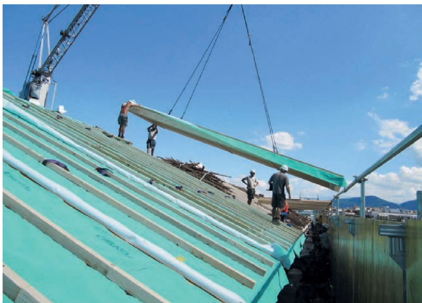
Pose d'un élément préfabriqué de toiture
