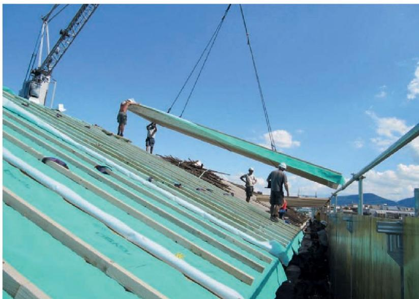
*Pose d'un élément préfabriqué de toiture*
