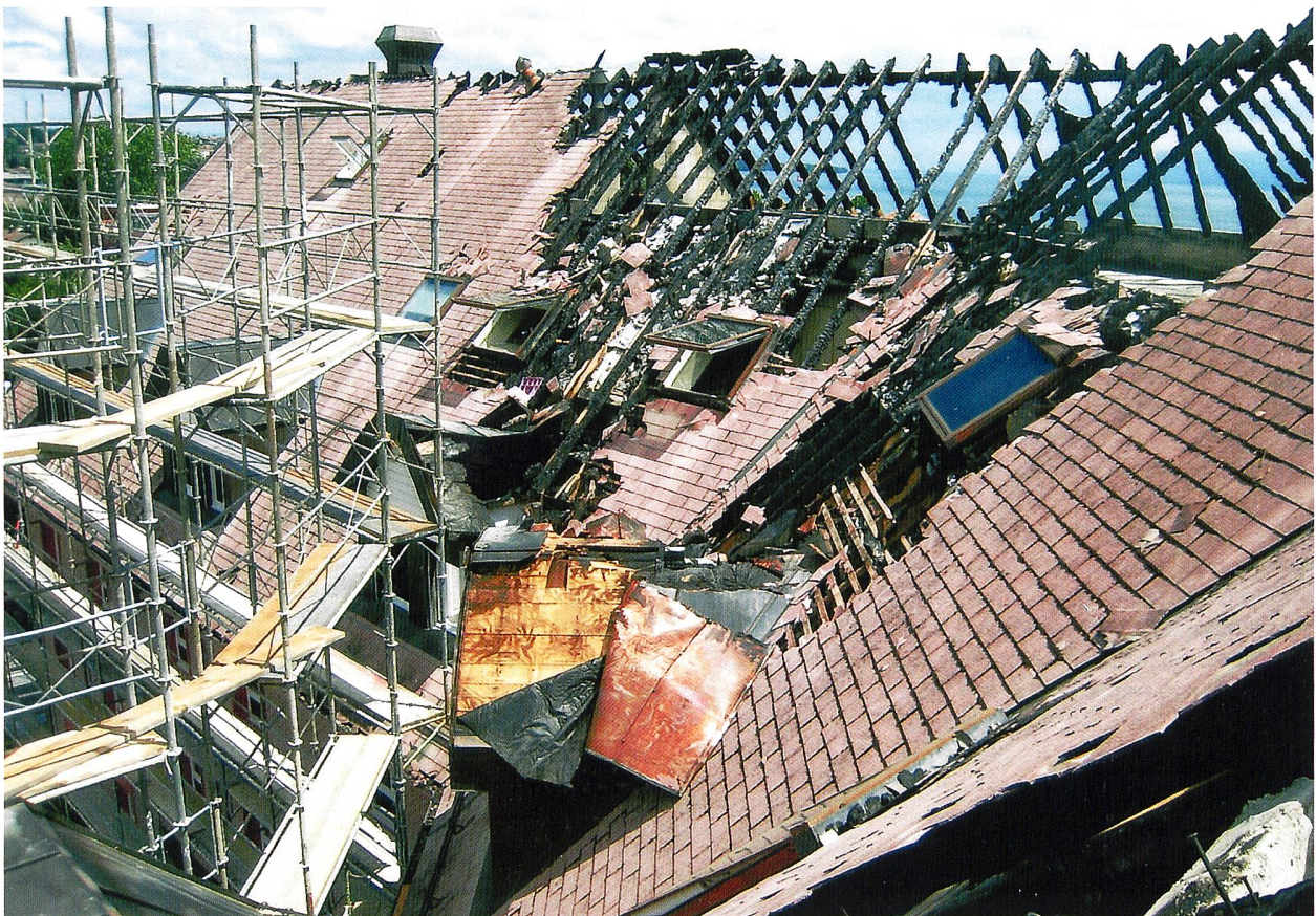
Très vite, la coopérative a fait installer des échafaudages pour pouvoir commencer les déblaiements. SCHR
