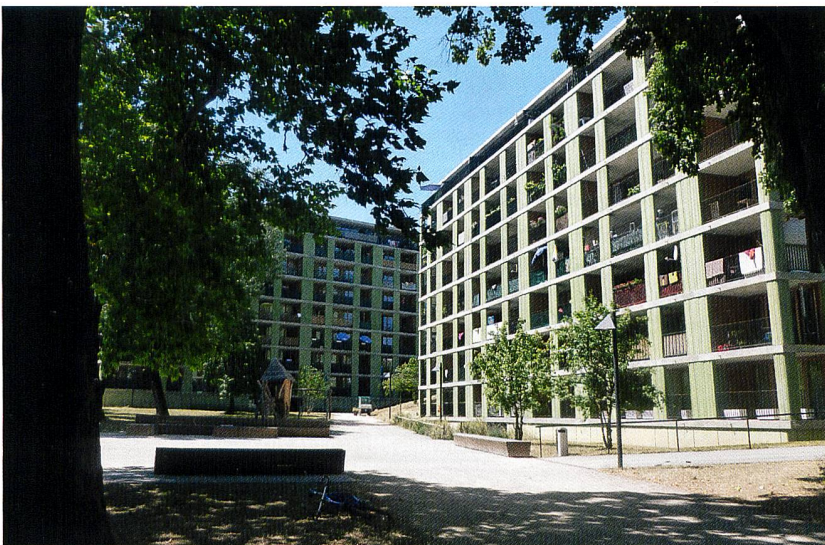
La FVGLS souhaite pouvoir améliorer la mixité sociale de ses futurs immeubles. Ici avenue de France 19 et 21, construits entre 2009 et 2011. ©Borcard
