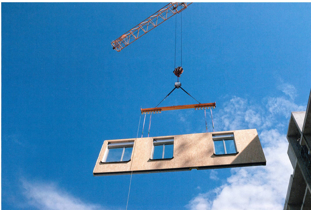
Les éléments sont installés un par un. Bellmann/DR
