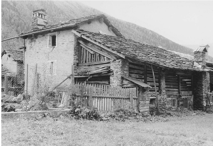
Ill. 6: Lillaz (Cogne). Les deux corps du modèle de maison, adopté par la population locale, se distinguent nettement. Noter l'usage parcimonieux du bois, comparé à la mise en œuvre des madriers ou des troncs à Valnontey.
