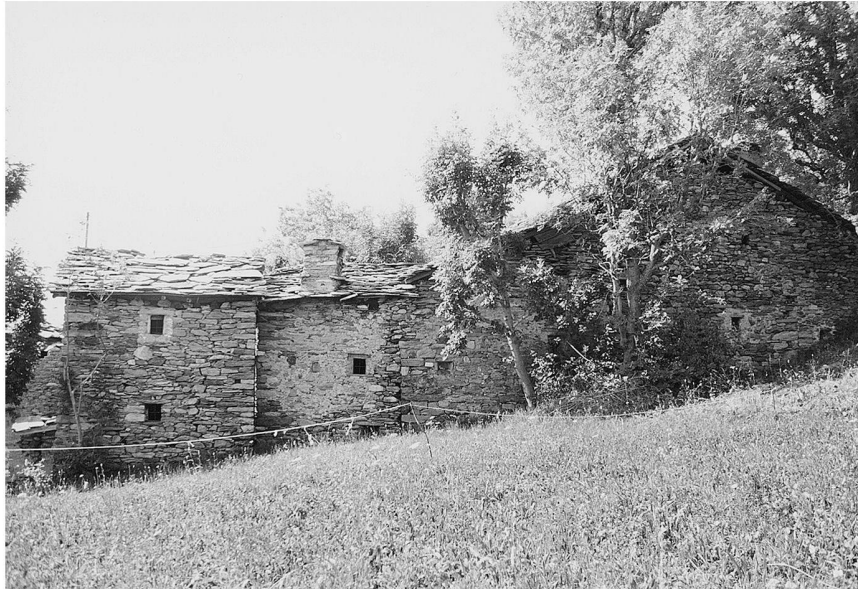
Ill. 1: Echallogne (Arnad). Adret de la basse vallée centrale. Un exemple d'ensemble complexe. Les maçonneries non enduites permettent une «lecture» des phases de construction.
