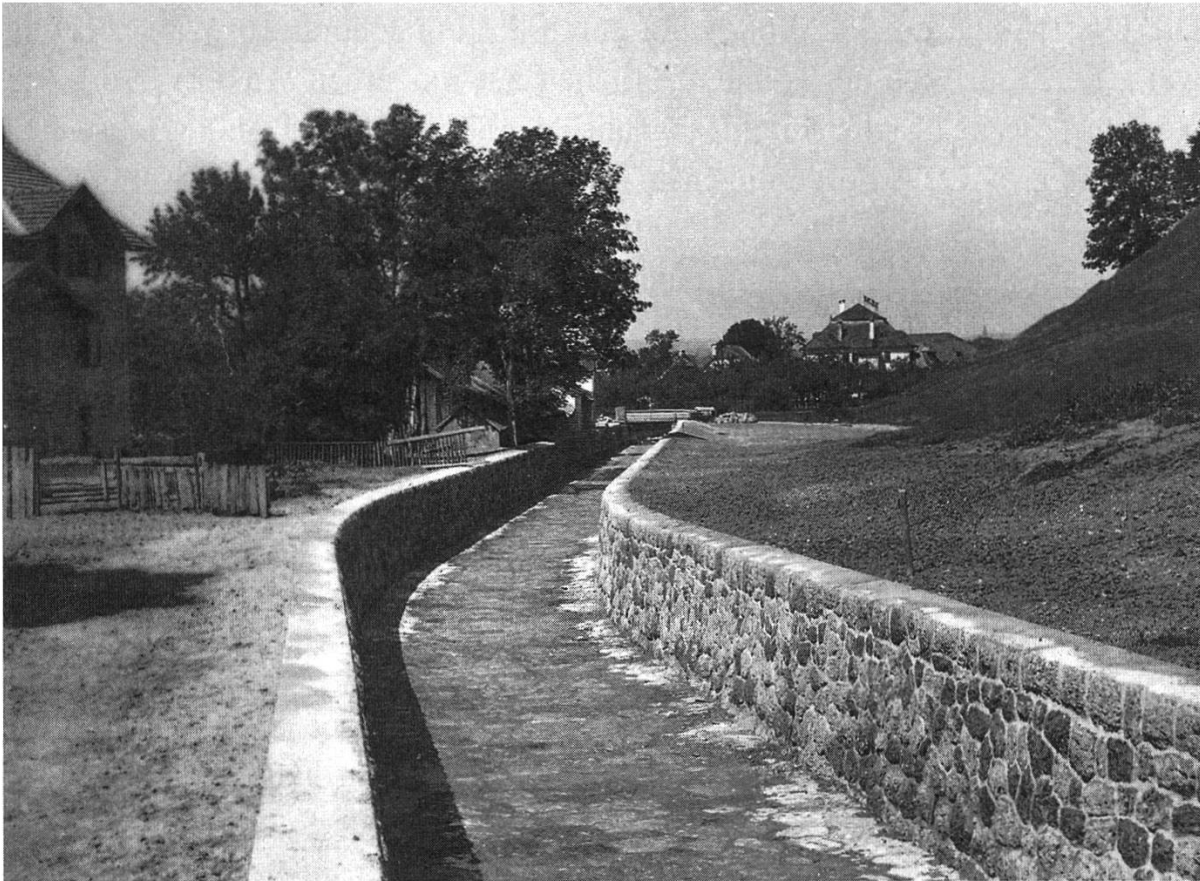
Abb. 2: Der kanalisierte Alterbach in Obergnigl um 1905. Quelle: Archiv der Wildbachverbauung Salzburg.
