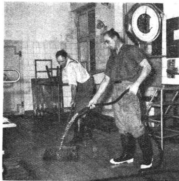
Um 16 Uhr werden Fabrikationslokale und Maschinen täglich mit Heißwasser ausgewaschen. Arbeiter der Nachtschicht müssen die Fabrikationsräume ein zweites Mal schrubbren, die Maschinen auseinandernehmen, reinigen, wieder montieren und mit Dampf sterilisieren. Morgens, bei der Ablieferung der Milch, ist alles rein und steril.
