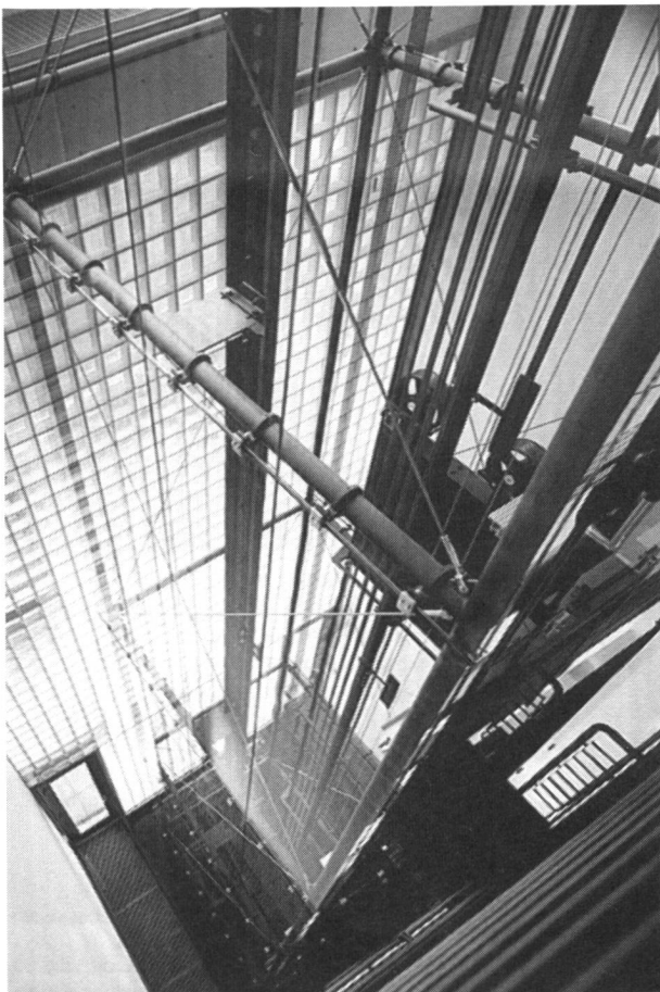
Glaslift. (Foto: Croci & du Fresne)
