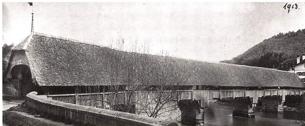
Neubrücke. Die Holzkonstruktion ruht auf Steinpfeilern. (Foto: IVS, mit Bewilligung des Eidg. Archivs für Denkmalpflege)
