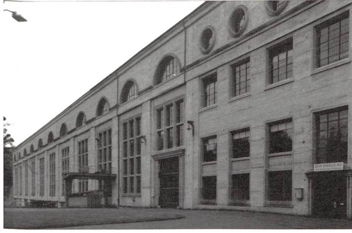
ablassstollens – zu einer eindrücklichen Gesamtanlage. Auch beim Schalthaus sind die Wände aus Beton, die Decken und der Dachstuhl aus Eisenbeton erstellt. Wiederum nimmt die Gestaltung die Motive – zum Beispiel die Fenstereinfassungen mit Kunststein, Gurtgesimse und die darüber liegenden Bogensegmentfenster – auf, verzichtet aber auf die Gliederung mit Lisenen. Die rasterartige Anordnung der Fenster betont vielmehr den Charakter eines Industrie- und Lagergebäudes.
