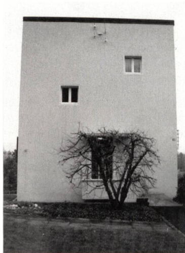
Eduard Lanz gestaltete die Nordfassade des Hauses Schibli als spannungsvolle Komposition von Wandöffnungen.
