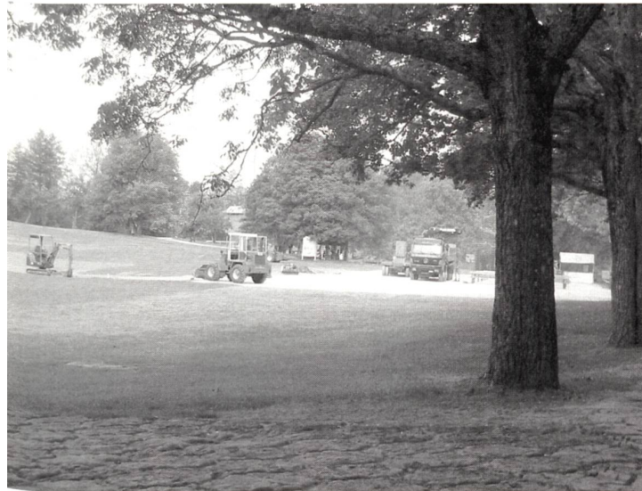
Rekultivierungsarbeiten mit grobem «Geschütz» nach dem Gurtenfestival 2004.
