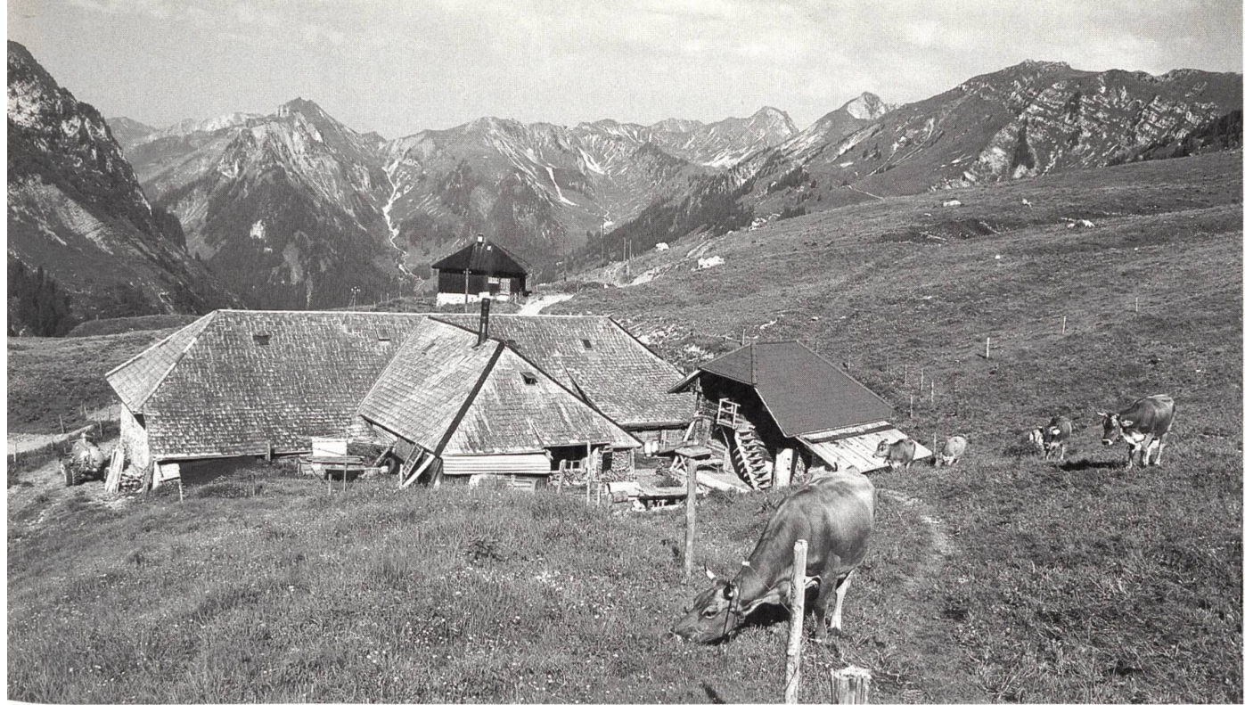
Därstetten, Obere Walalp: Komplexes Algebäude mit Querfirst und Schleppdach.
