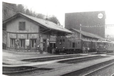
Das anno 1925 von Thun Scherzigen nach Bern Fischermätteli gezügelte Bahnhofgebäude ist seit dem 1. Juni 1986 seiner Funktion beraubt, da seither die Züge die neu erstellte Haltestelle Bern Ausserholligen GBS bedienen.
